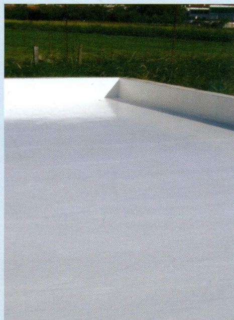
Applicazione su copertura piana
